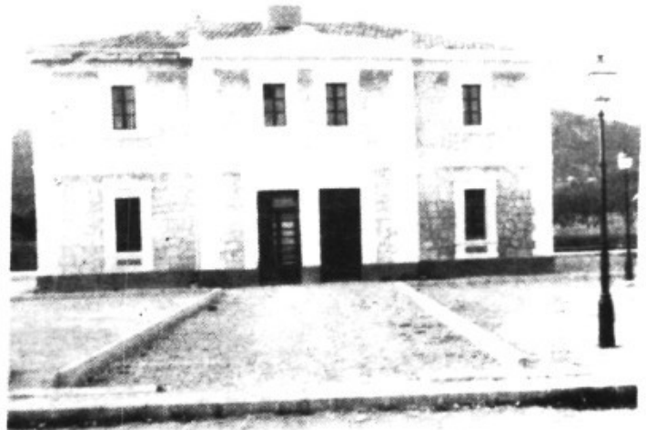
La obra a medio empezar: La de la estación (foto J. Pons)
