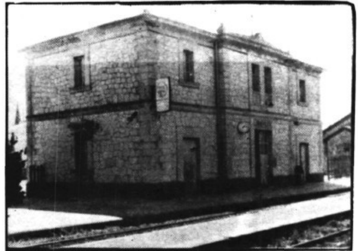
Así era antes de la reforma, la estación. (foto XISCO)
