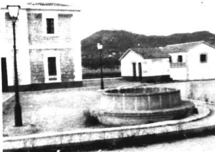
Hace año y medio, y las obras de la estación no han sido acabadas (Foto J.Pons)
