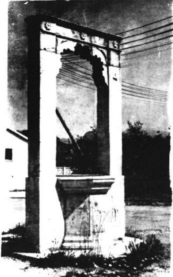
Definitivamente, la cisterna de delante de la estación, será cambiada de sitio.
