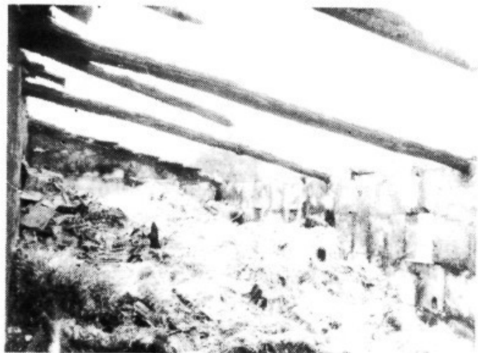
Así quedó el porche después del incendio, sofocado por la motobomba contra incendios. (Fotos Xisco).
