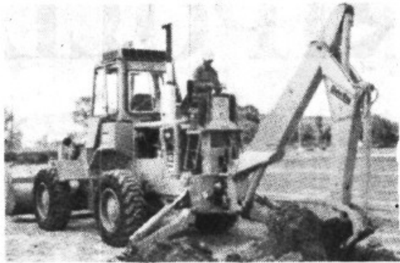
Pala cargadora retro excavadora, con martillo hidraulico
