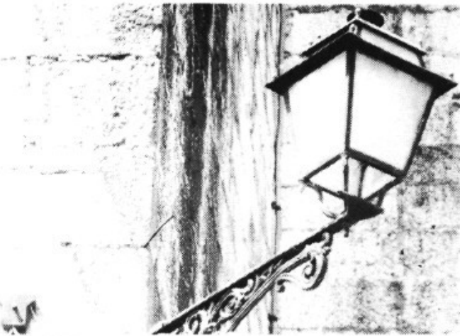
El alumbrado público es deficiente (Foto SANS).
