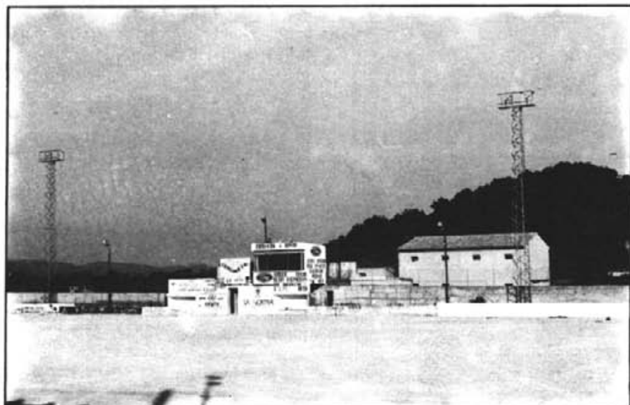
Torres per a la nova il·luminació del camp de futbol.
