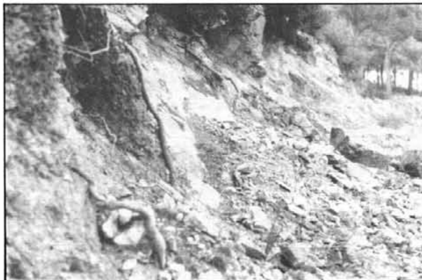
L'obertura de camins i carreteres sense protecció provoquen una pèrdua de sòl irreversible.
