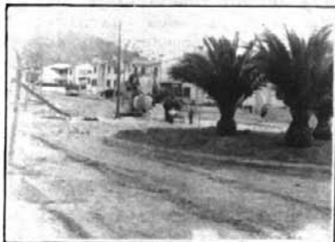
plaça de Sa Bassa d'En Fessol en obres. Gener 89
