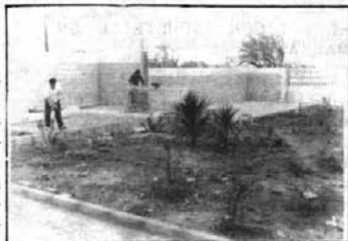
Obres que es realitzen al cementiri. Gener 89
