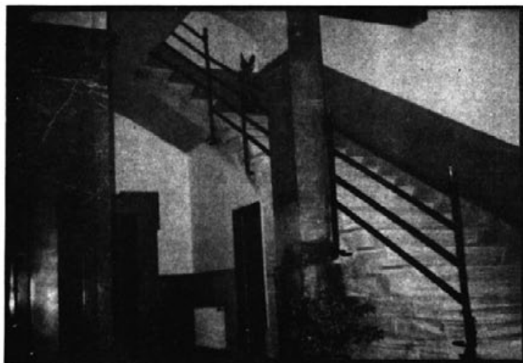
Detalle de la escalera
