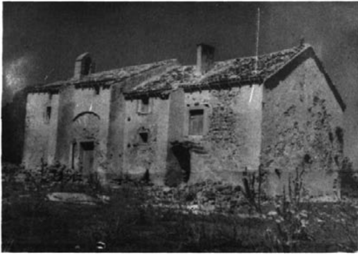
Església de Bellpuig. Vista completa de la part que dóna a mitjorn.
