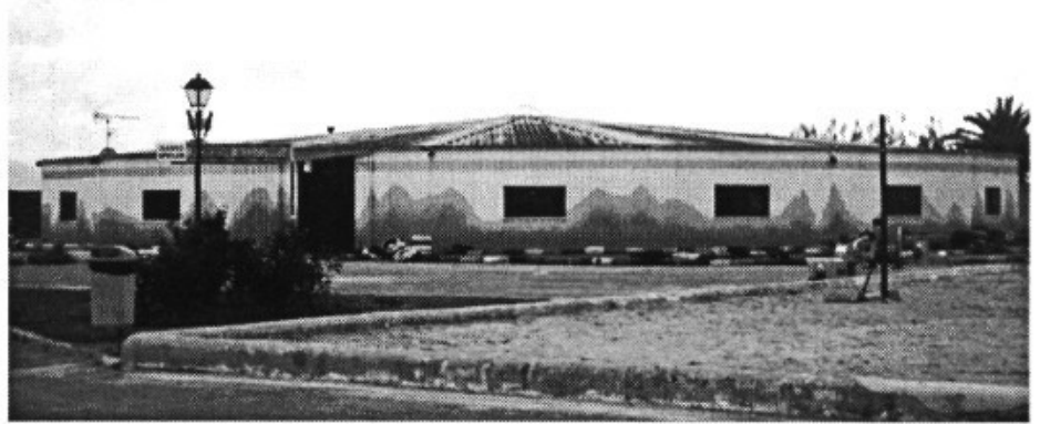
Elementos degradantes como esta carpa tendrán que ser eliminados
