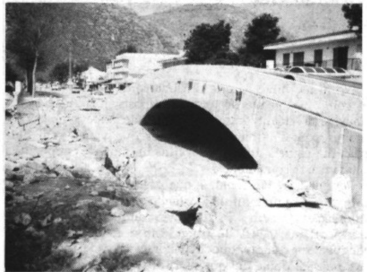
Puente en construcción en Av. Pedro Mas Reus
