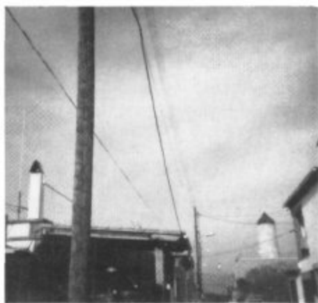
Cables colgando hasta el próximo mes.
