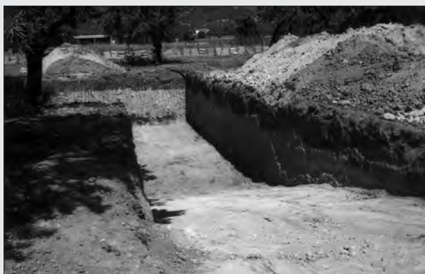
Excavacions per a edificar.
