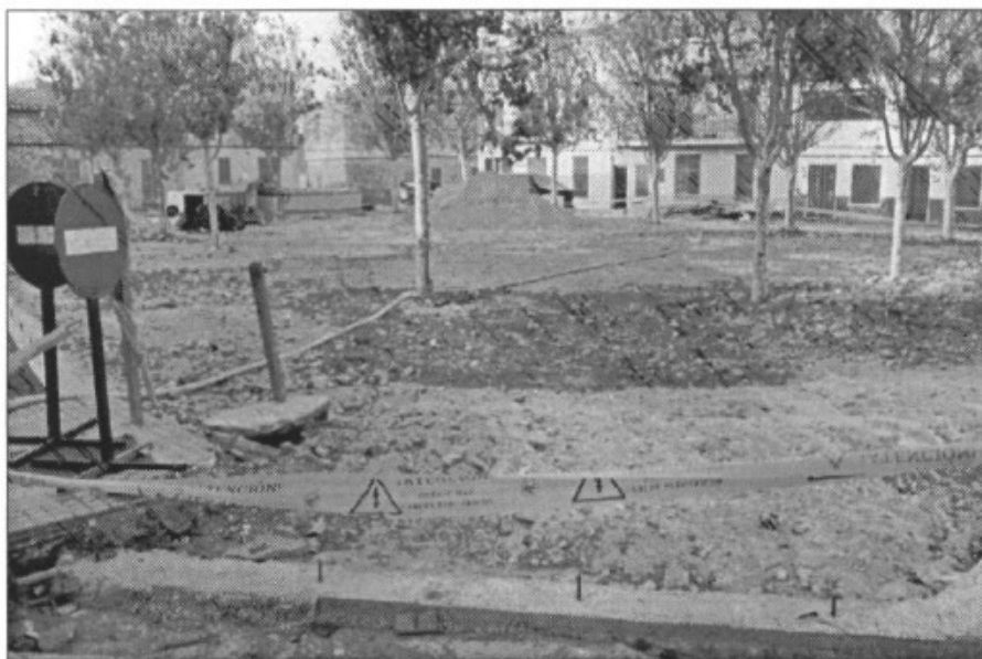
La plaça Major està en obres. Fotografia: Joan Ferrer.
