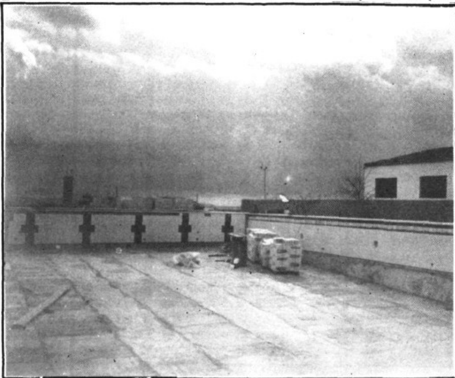
Piscina municipal en obres.
