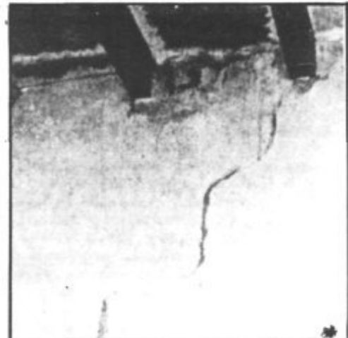
Grietas. Las anchas grietas aparecidas a ambos lados de la capilla del "Roser", y tanto en su parte inferior como superior, amenazan ya la estructura del edificio y reclaman urgentes medidas de reparación.
