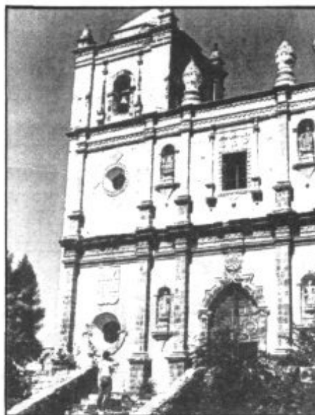
PARTE SUPERIOR DE LA FACHADA DE ACCESO DE LA IGLESIA DE SAN IGNACIO
