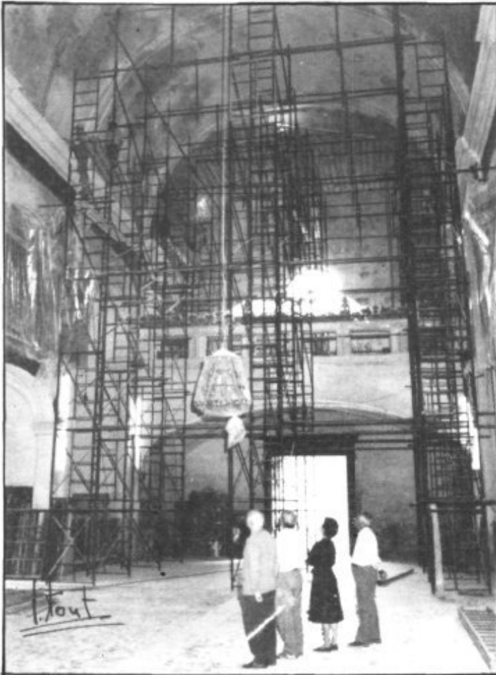
LA FOTO ES UN EXPONENTE DE COMO SE VIENEN REALIZANDO LAS OBRAS
