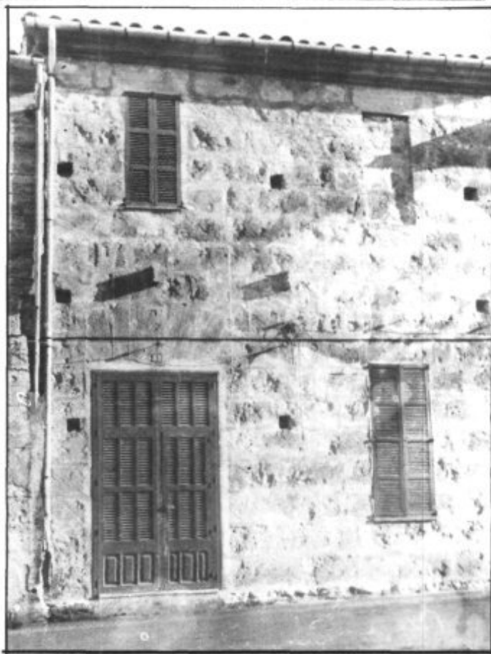
CUANDO LAS "MONGES DE SA BASSA" LLEGARON A PETRA, EN 1863, FIJARON SU RESIDENCIA EN LA CALLE DE LAS PARRAS, Nº 3
