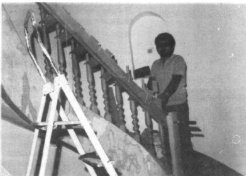
ARDUA Y DIFÍCIL FUE LA TAREA DE MONTAR LA BARANDILLA DE LA ESCALERA EN SU SITIO.
