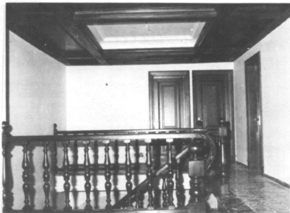
CONJUNTO DE CARPINTERÍA COLOCADO EN UNA CASA DE ARTA
