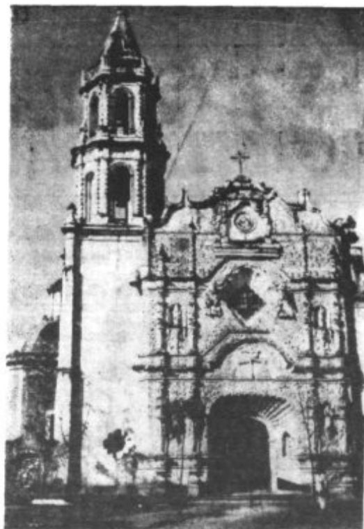
Iglesia de la Misión de Santiago de Jalpán. E. P. Serra encontró una pequeña iglesia de adobes, pero edificó este hermoso templo. Es la única construcción suya que todavía existe.
