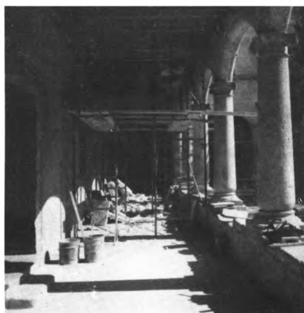
Restauració del claustre del Convent
