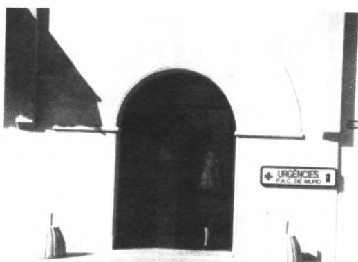
Equipament i reforma del PAC 12.917.387 ptes.
