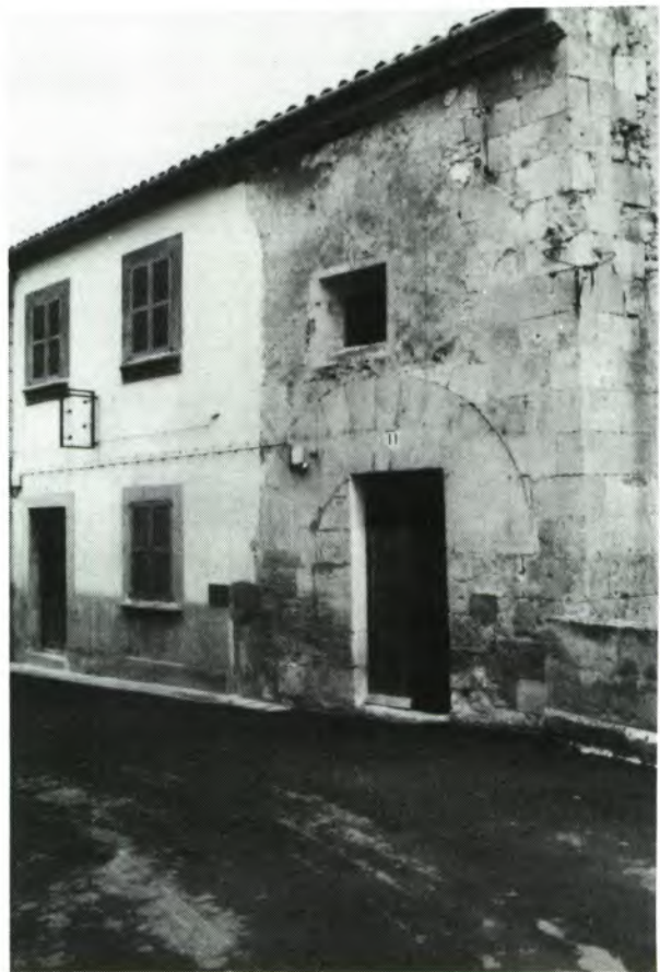
La casa n.º 11 (a la dreta) fotografiada abans de la seva demolició.
