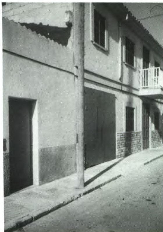
Postes con peligro. En Muro los hay muchos, sobre las aceras, circunstancia que consideramos incorrecta y peligrosa, ya que de noche no tienen señalización fluorescente ni luz alguna. Tratándose de postes para conducción de líneas eléctricas, ésto no debería de ocurrir. ¿O no?
