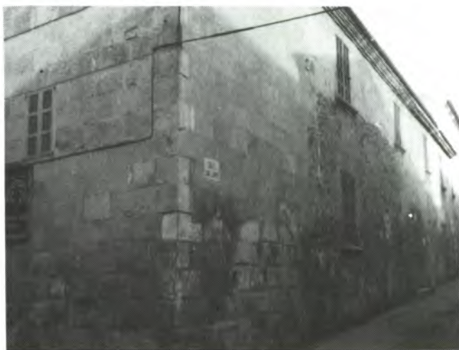
FITXA 7. FAÇANA DE LA CASA AL CARRER DE SANT JAUME, CANTONADA MIQUEL TORTELL (AVUI CINE).
