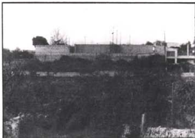
PISTAS DE TENIS DE LAS COMUNAS DE CA'N OLIVER Y TERRENOS COLINDANTES Zona de servicios (deportiva)
