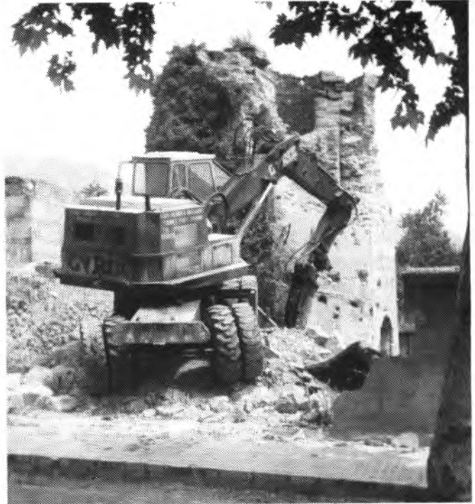
Enderrocament de la Torre d'Electricitat.
