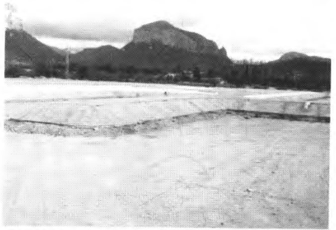
Alaró ja té depuradors.
