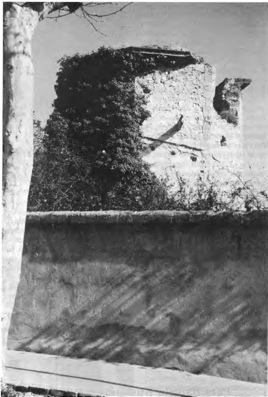
Restes de la Torre de la 1ª fàbrica d'electricitat de Mallorca.
