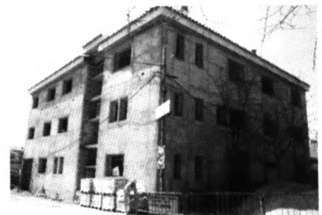
* Construcció del Centre Sanitari 13
