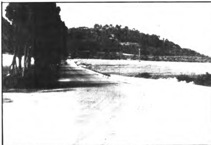
Aspecto que ofrece la curva conocida como "Volta des Sipli" en la carretera d'es Comellà Fondo, una vez finalizadas las obras. Foto: Forteza Hnos.
