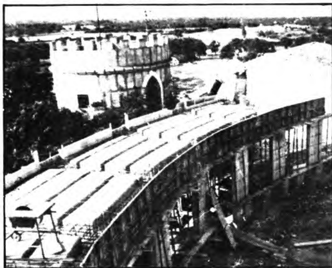
Uno de tantos rincones del Complejo, en obras.
