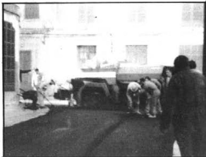
Els operaris procedeixen a donar a Sa Plaça una nova imatge. La deteriorada calçada sembla ara una autopista. (Foto J.Barceló)
