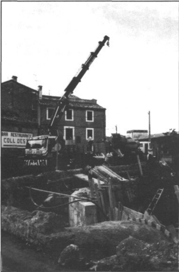
Obres d'ampliació del pont
