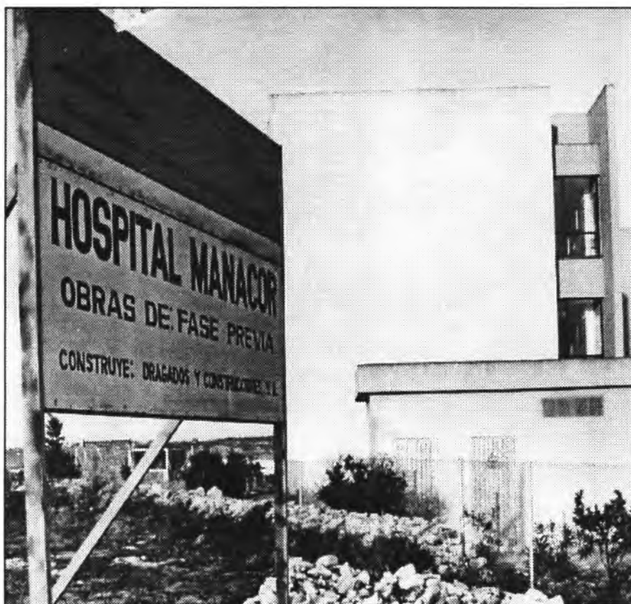
Les obres de l'hospital comarcal continuen a bon ritme.
