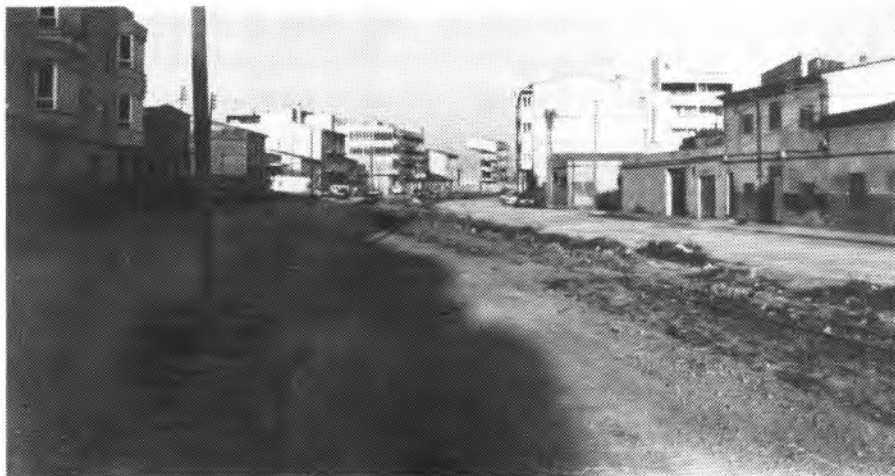
Sembla segur que les obres del passeig Ferrocarril s'acabaran abans del proper estiu.
