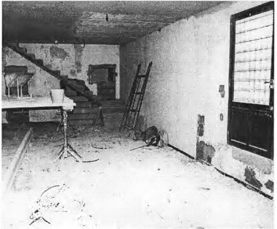
Les noves oficines on s'ubicarà el servei de recaptació estan en obres
