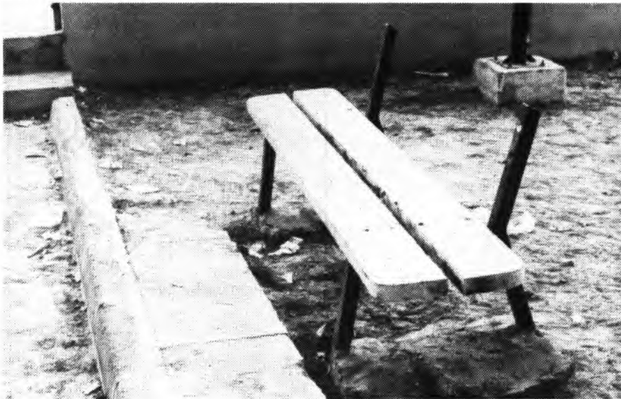
Un dels bancs de la Plaça del Llop sense espatllera. El terra es veu descuidat i brut.
