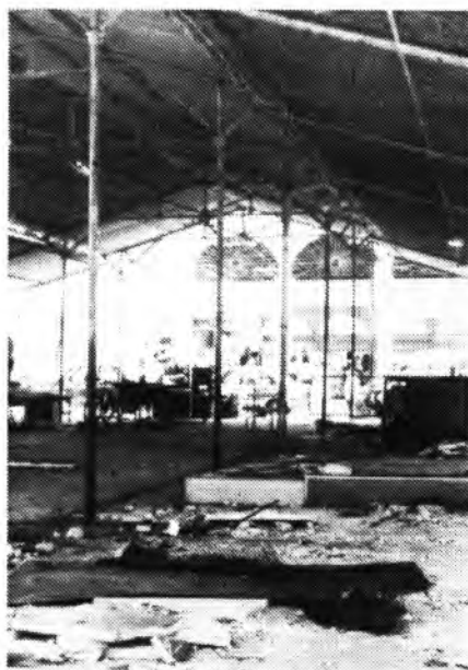
Aquesta setmana es començarà a desmontar la vella estructura.
