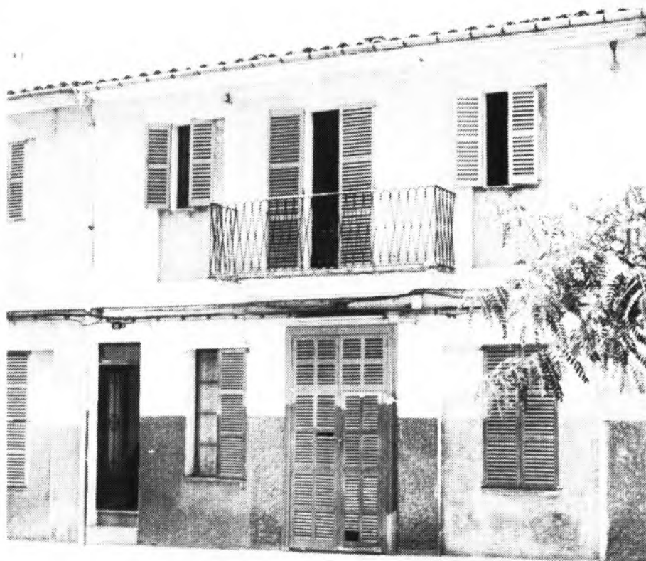
Inmueble en el que se efectuó la operación contra el tráfico de la droga.
