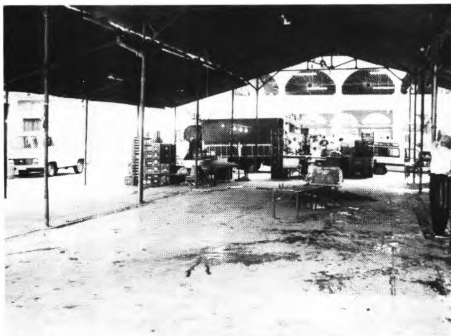
La part inferior fou desallotjada per poder començar la segona fase de les obres.
