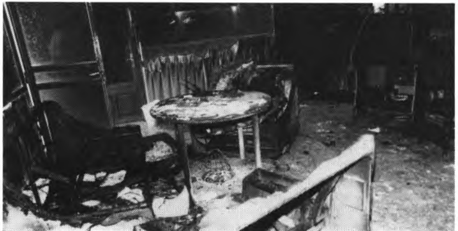
La sala en la que el fuego afectó quedó completamente calcinada. La vivienda es propiedad de la familia Sureda-Sureda.
