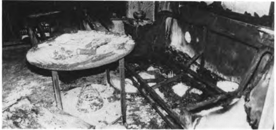
La vivienda afectada se halla ubicada en la calle La Niña de Son Carrió.
