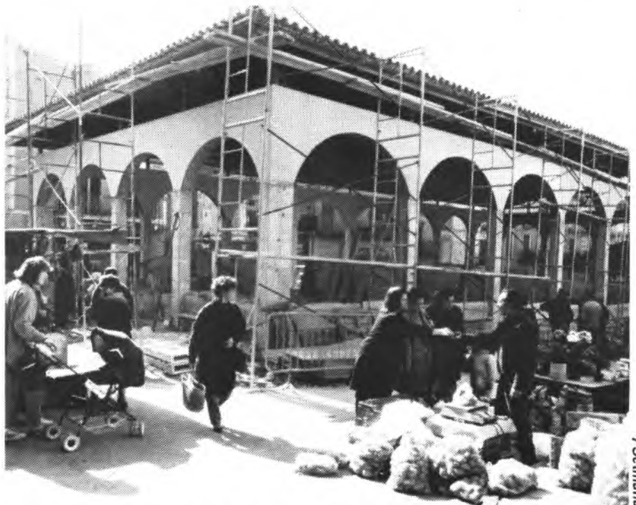
Imatge actual de les obres del nou edifici de Sa Plaça.
