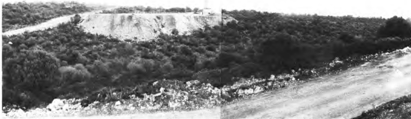
Vista de la carretera, hace unos meses. En primer término la vaguada del torrent dels Domingos, al fondo la torre del agua
