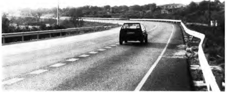
El accidente ocurrió en la madrugada del pasado lunes en el kilómetro 4'600 de la carretera que conduce de Manacor a Porto Cristo.
