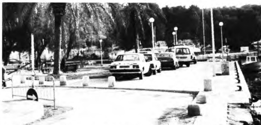
Les obres del passeig del parc del riuet estan quasi enllestides, sols manquen petits detalls.
