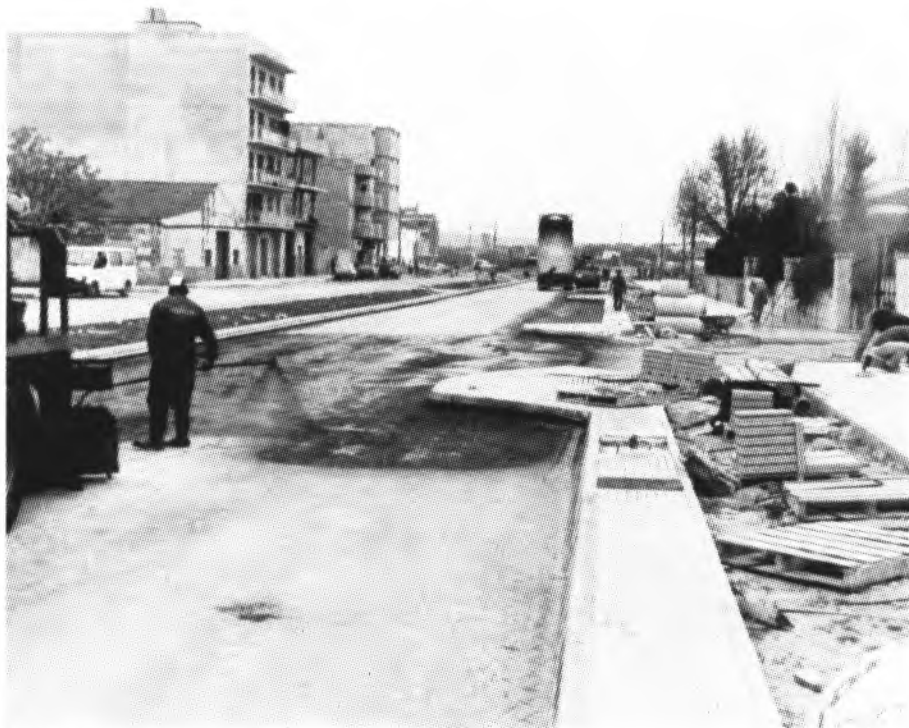
Así se encuentran las obras en la actualidad
