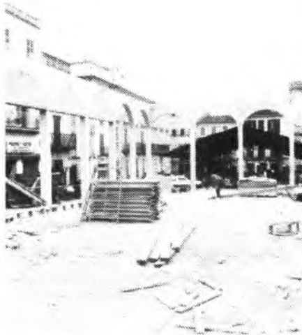
Moment actual de les obres de la primera fase de Sa Plaça d'abastiments
