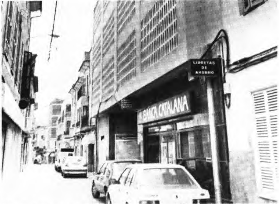
Els aparcaments consten de tres sótans, quatre pisos, un entresolat i una terrassa.
