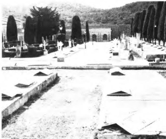
S'han acabat les obres de pavimentació de la primera meitat del cementeri. La diferència entre les dues zones és notable.
