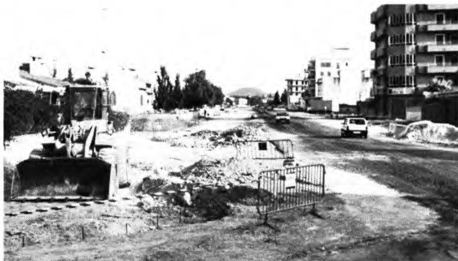
Les obres de l'avinguda del Parc ja han començat.
