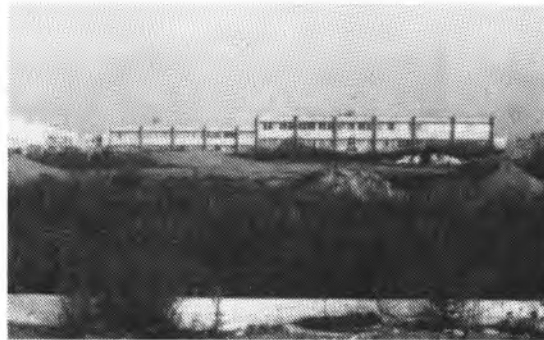
Terreny on es construirà el Poliesportiu M-4 ubicat darrera l'Institut Mn. Alcover
